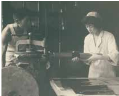
昭和の作業風景
