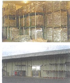
冷却設備・冷蔵倉庫
